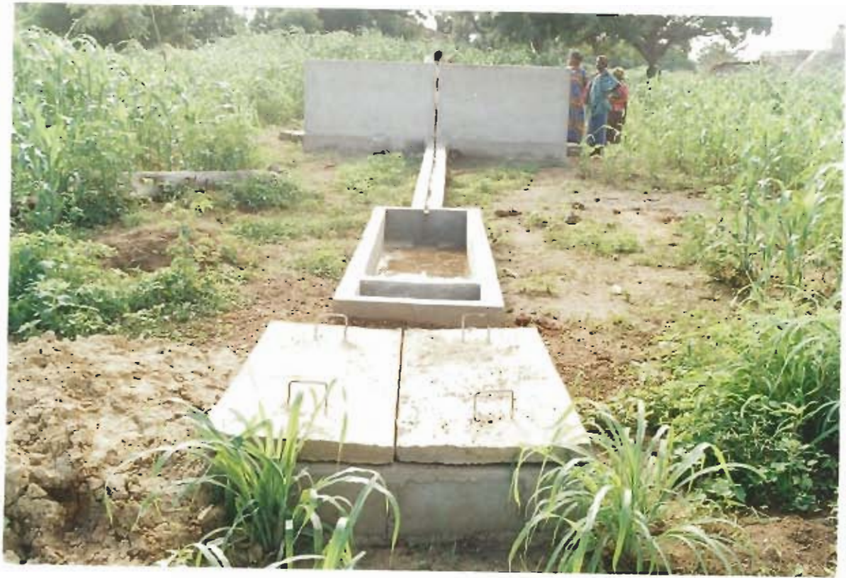
Vue générale du forage de Gonsin.
