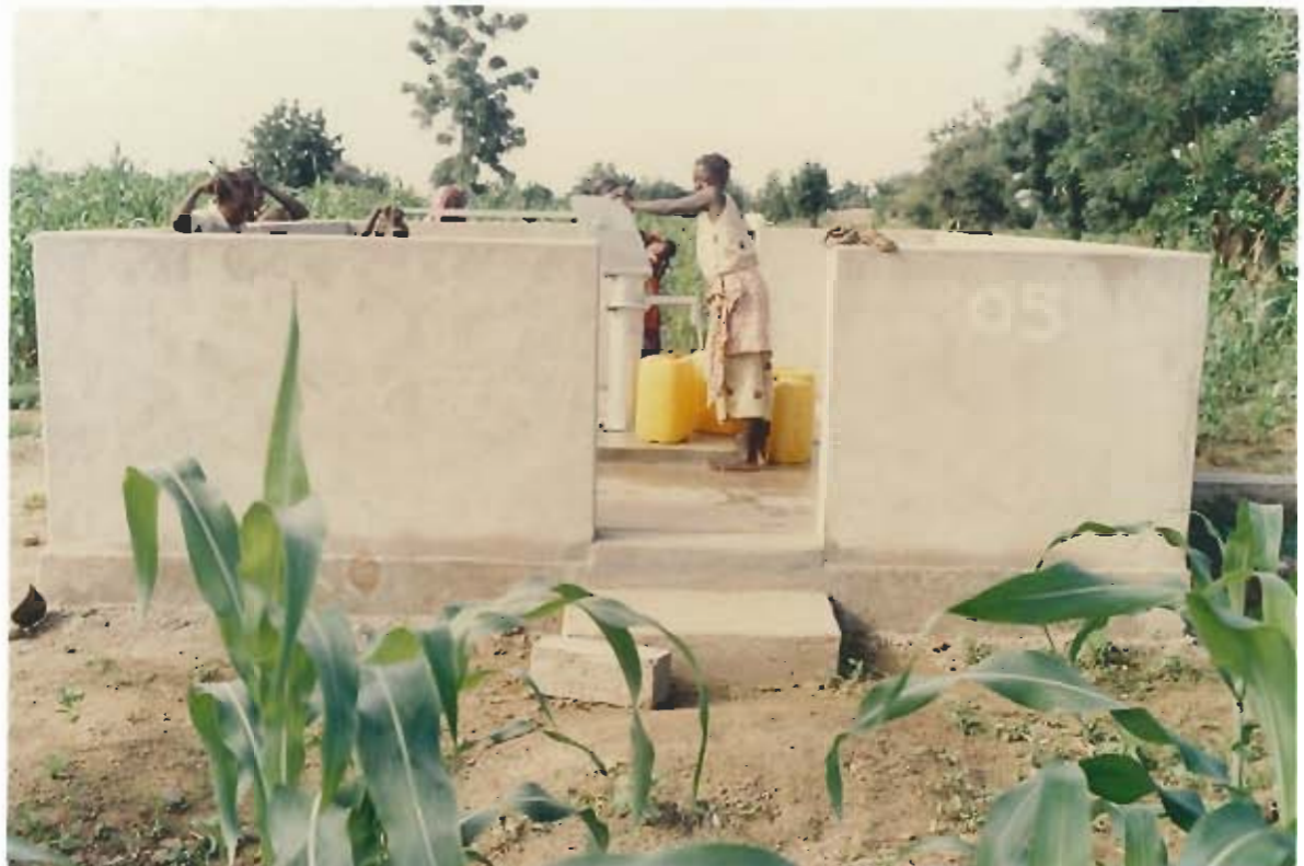
Vue rapprochée du muret du forage de Gonsin.
