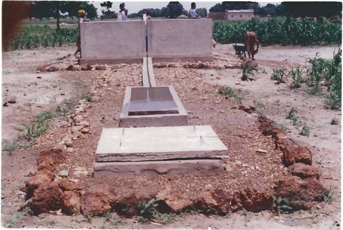
Vue générale du forage de Malenga (une superstructure bien aménagée).
