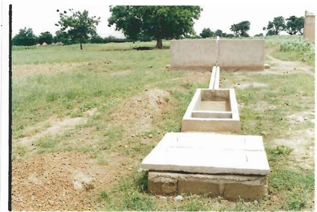
Vue générale du forage de Nénéogo.
