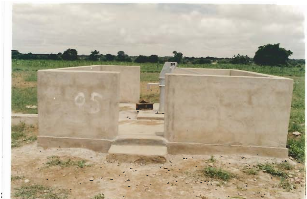
Vue rapprochée du muret du forage de Nénéogo.
