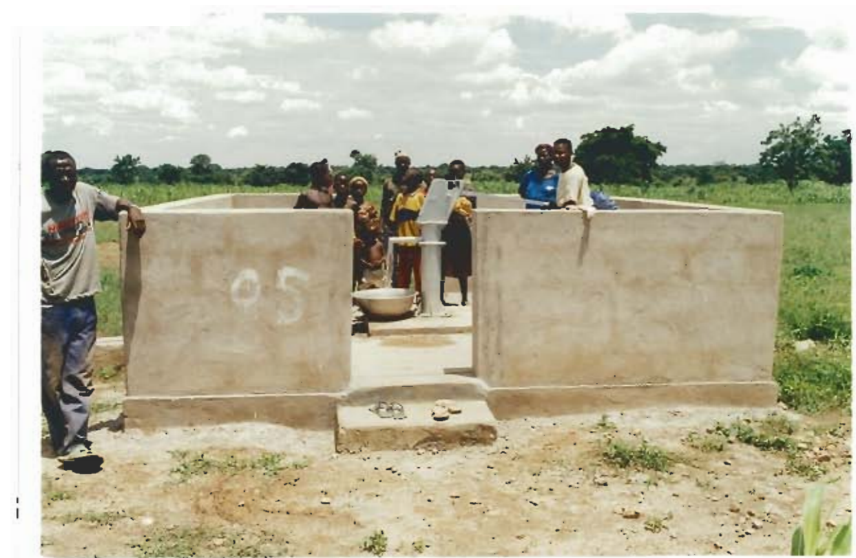
Les chaussures sont laissées à l'extérieur du forage pour maintenir la propreté.
