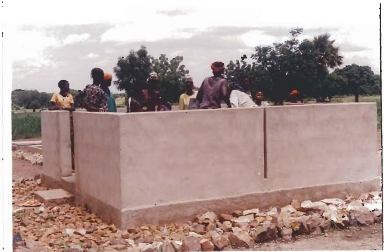
Vue rapprochée du muret du forage de Tougsi (Dialgaye).
