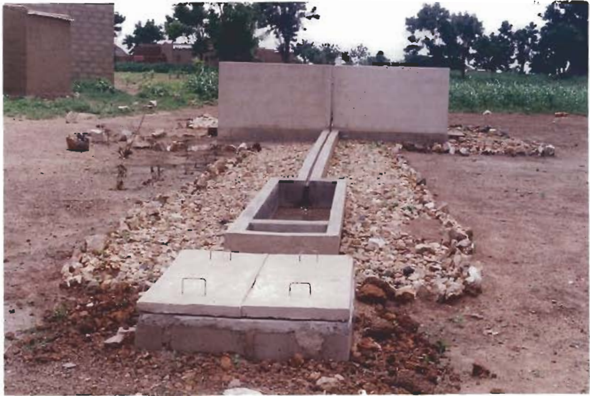
Vue générale du forage de Tougsi à Dialgaye (une superstructure bien aménagée).
