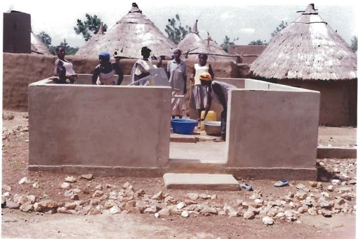
Vue rapprochée du muret du forage de Kobouré (Dassui)
